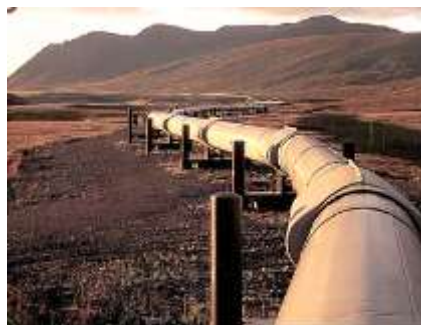
Магистральный нефтепровод ОАО «АК «Транснефть»
