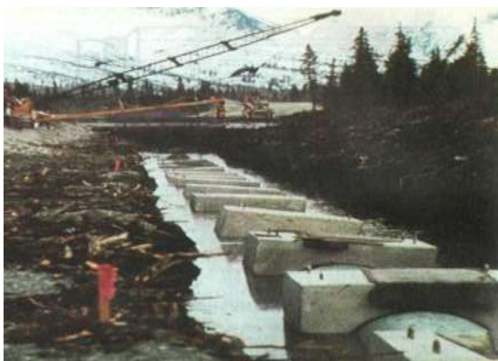
Рисунок 5. Балластировка одиночными железобетонными седловидными пригрузами
