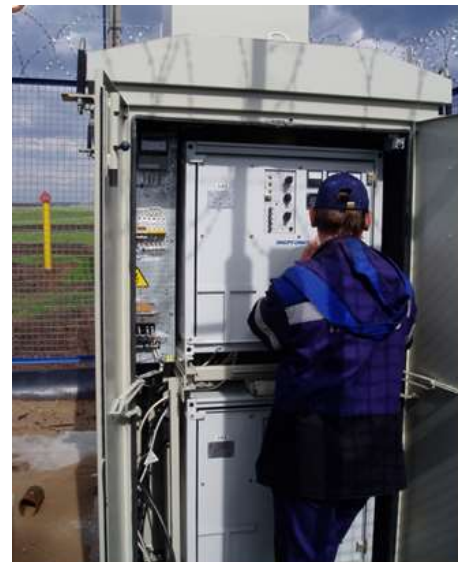
Снятие показаний приборов на СКЗ
