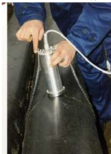
Измерение разности потенциалов между трубопроводом и землей
