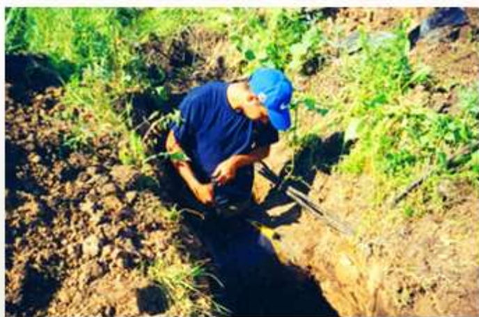
Измерение адгезии изоляционного покрытия в шурфе
